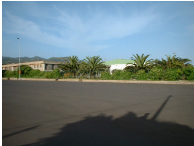
Vista general Instalaciones del Matadero Insular
