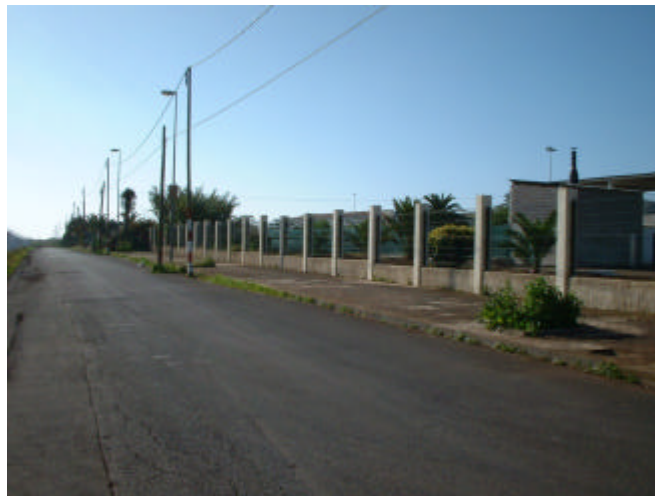
Camino de Acceso al Matadero Insular
