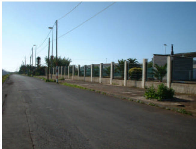
Camino de Acceso al Matadero Insular
